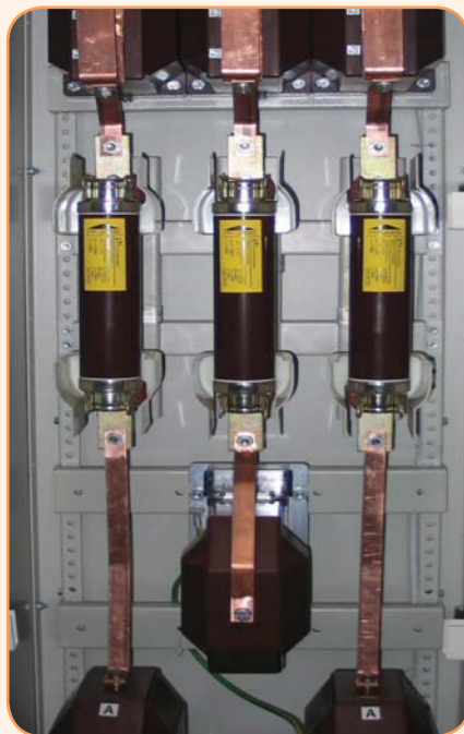
Внутренняя установка предохранителей
