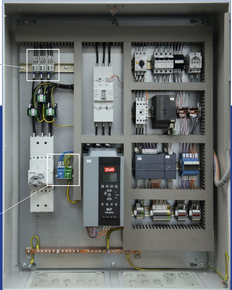
Пример применения кросс-модуля UVB в шкафу управления декантерной центрифуги
